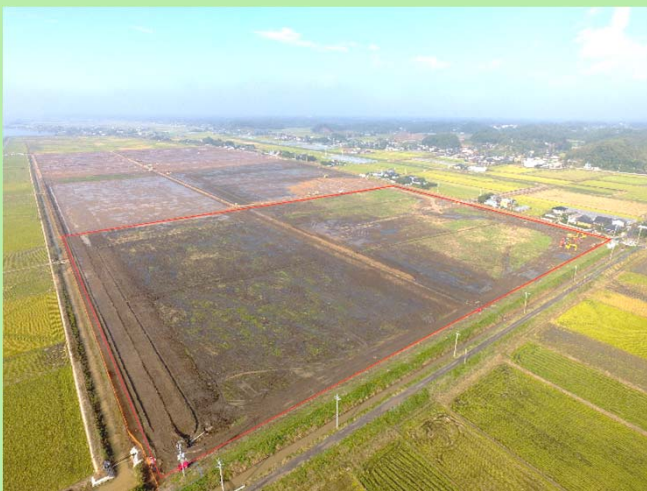
① 施工箇所 (伐木除根・構造物取壊完了時)
