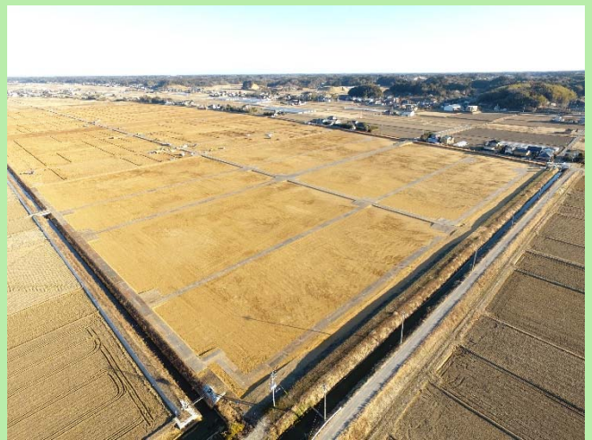
② 施工完了後
