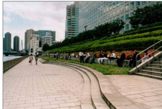
スーパー堤防整備後（隅田川 新川・箱崎地区）
