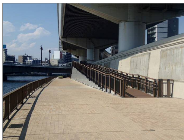
スロープ整備（隅田川 両国橋下流）
