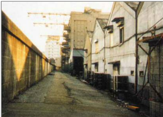
スーパー堤防整備前（隅田川 新川・箱崎地区）
