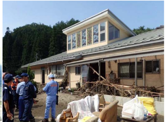
要配慮者施設(岩手県)
