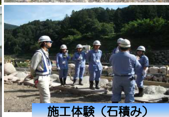
施工体験（石積み）
