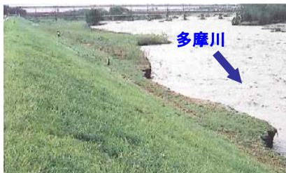
多摩川39.0k右岸侵食被害状況(H13)
