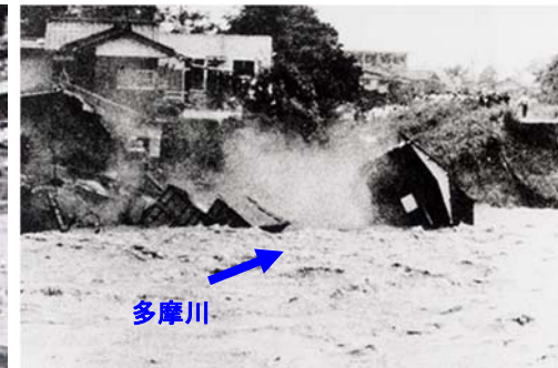
多摩川二ヶ領宿河原堰付近堤防決壊状況(S49)
