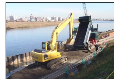
盛土材の搬入状況
