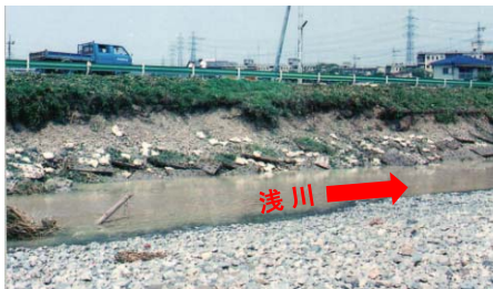
浅川6.0k左岸侵食被害状況(S57)
