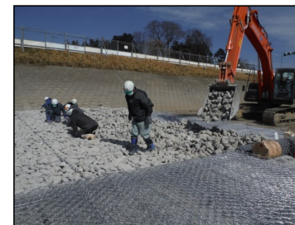
コンクリート殻の利用状況
