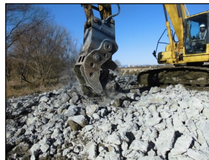
根固めブロック(2t)破碎状況
