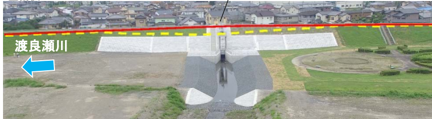
三栗谷排水樋管周辺の堤防整備状況
