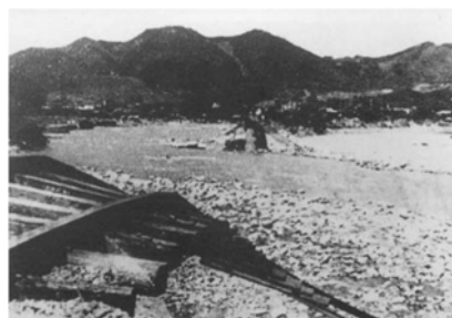
落橋した国鉄両毛線桐生川橋梁（桐生市）
