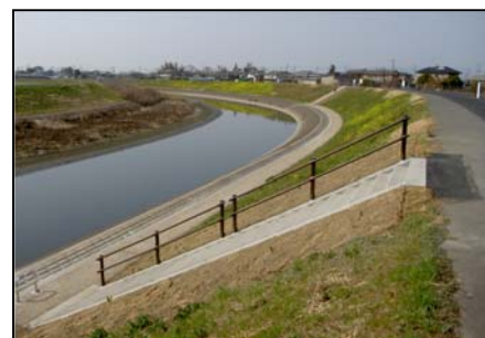
矢場川憩い・ふれあいネットワーク整備
