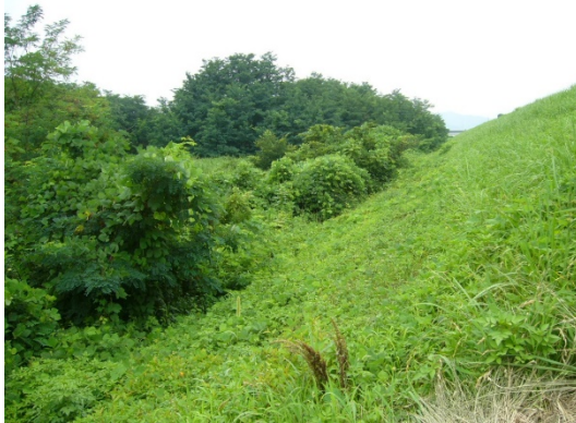
伐採対象となる河道内樹木の繁茂状況
