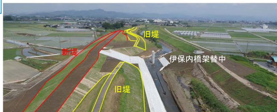
秋山川 河道拡幅状況(H27年6月時点)
