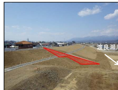
堤防整備の状況(渡良瀬川)
