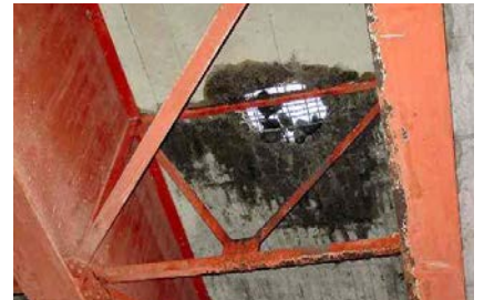
<上図：橋（床版）損傷の例>
