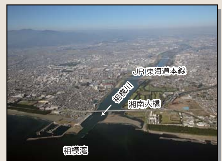
▲下流部(河口付近)
