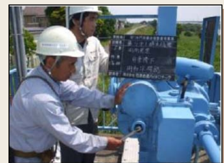
▲河川管理施設の点検状況
