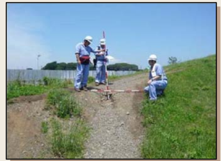
▲堤防点検の状況
