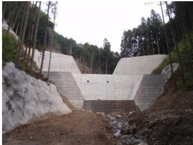
砂防堰堤完成イメージ
