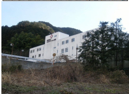
大久保沢の保全対象 (宏愛会第二リハビリテーション病院)
