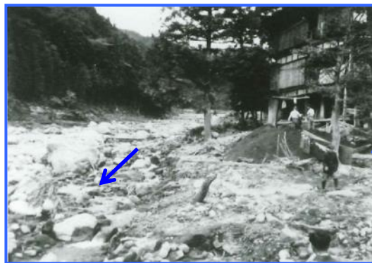
土石流に襲われた梨木温泉(昭和22年)
