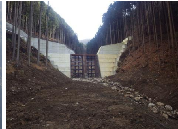
砂防堰堤完成イメージ
