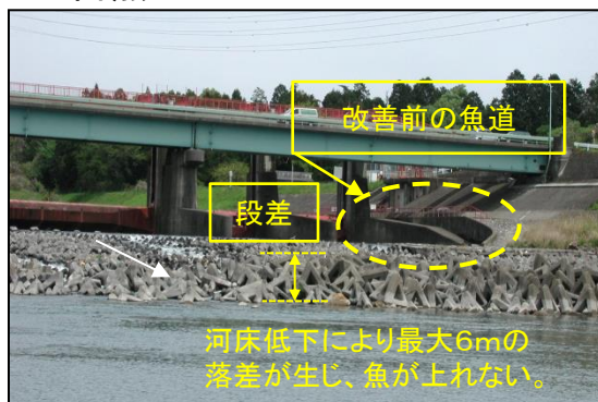
河川横断施設における段差
