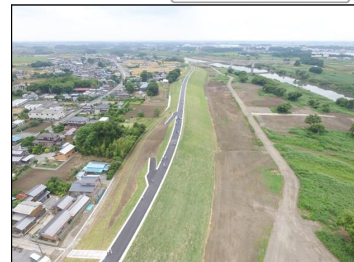
整備された堤防(決壊地点)
