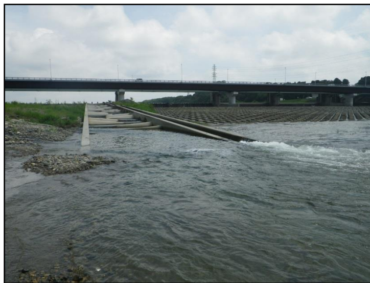
勝瓜頭首工に設置した魚道
