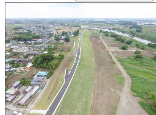
整備された堤防(決壊地点)
