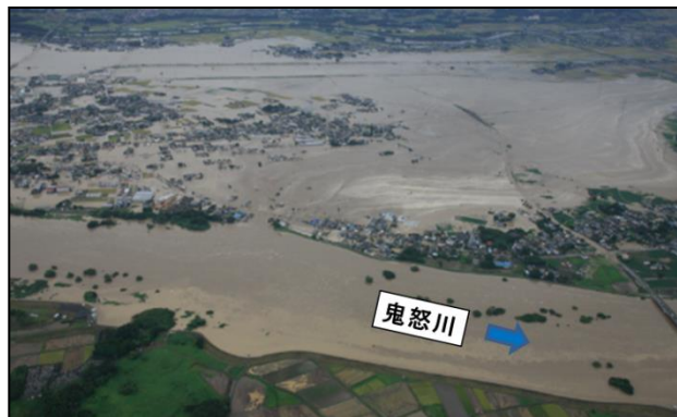
決壊箇所全景
