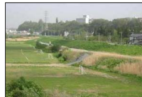
堤防が急傾斜で水辺に近づきにくい
