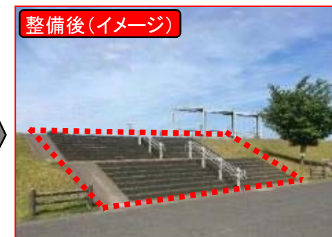
堤防の斜面が利用しやすくなるよう、階段護岸の整備を実施
