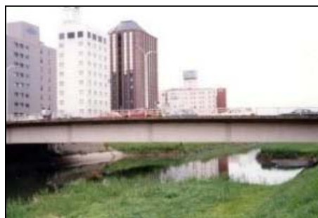
河川敷の管理用通路がないため、 上下流への移動が困難
