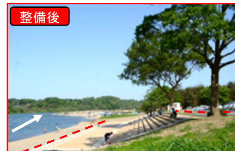
親水護岸の整備を実施
