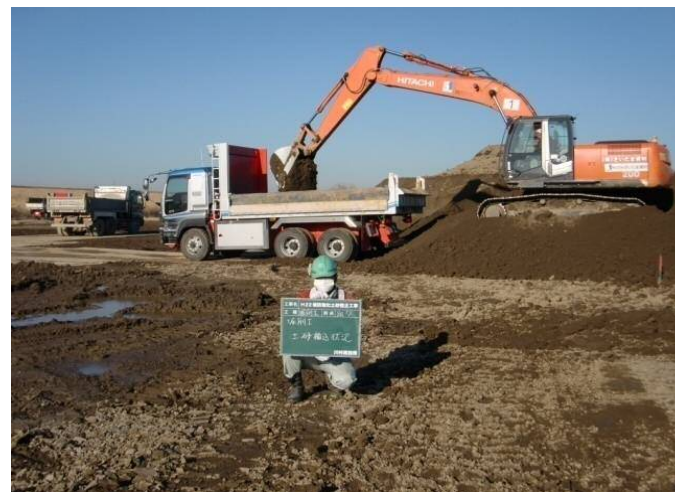
掘削土の積込・運搬
