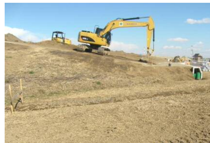
築堤盛土状況
