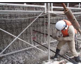
せん断補強鉄筋挿入状況
