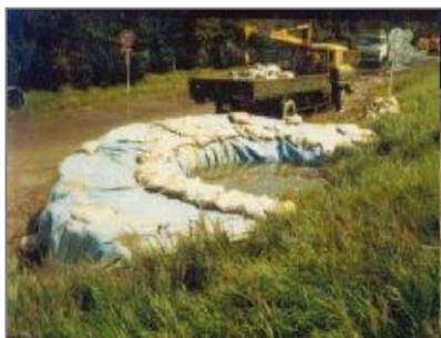
千葉県松戸市漏水状況 (S57)
