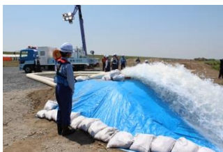
排水ポンプ車による 緊急排水活動
