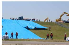
水防団による訓練 （裏シート張り工）
