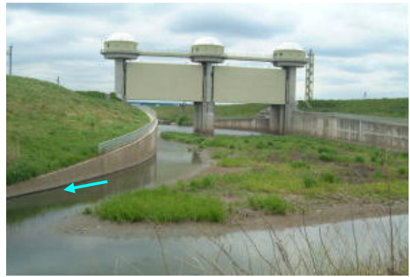
写真 3-3 玉作水門下流の土砂堆積状況
