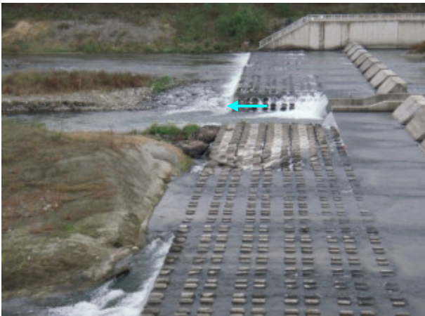
写真 3-4 明戸床止め下流の河床低下状況
