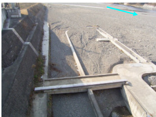
図 3-4 六堰流水改善施設への土砂堆積と掘削後の状況
