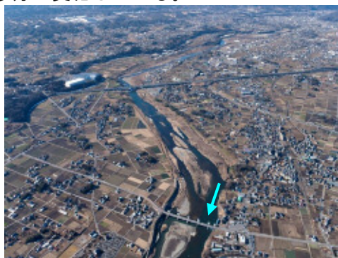
写真 1-1 六堰付近（88.0k 付近）
