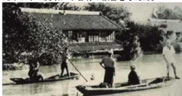
写真 1-12 カスリーン台風時の浸水状況 (古谷村：現川越市)【出典：写真集荒川(埼玉県)】
