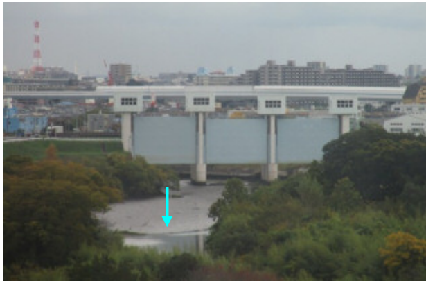
写真 3-2 昭和水門下流の土砂堆積状況
