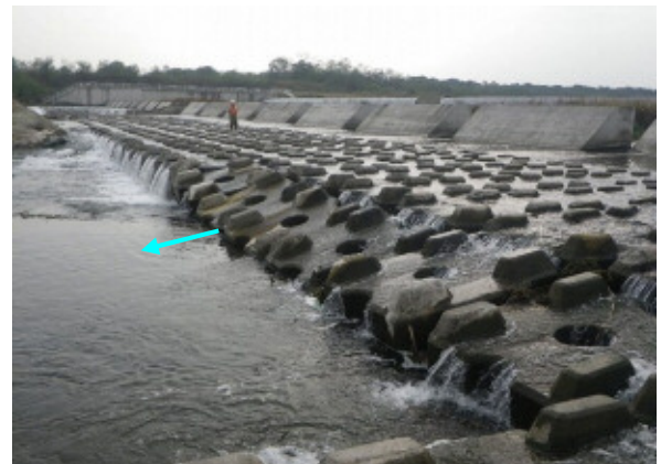
写真 3-4 明戸床止め下流の河床低下状況
