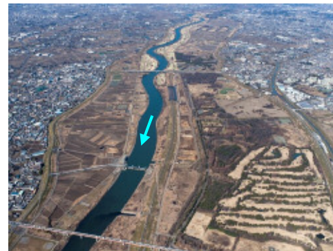
写真 1-4 秋ヶ瀬取水堰付近（36.0k 付近）
