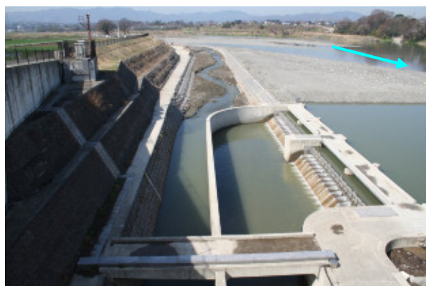
図 3-4 六堰流水改善施設への土砂堆積と掘削後の状況
