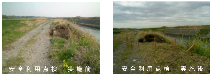
写真 1-16 安全利用点検の状況（実施前・後）
