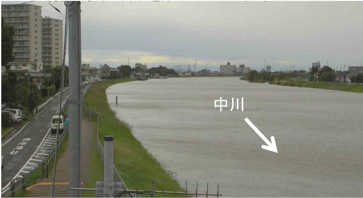
中川下流部(東京都足立区付近) 出水状況
