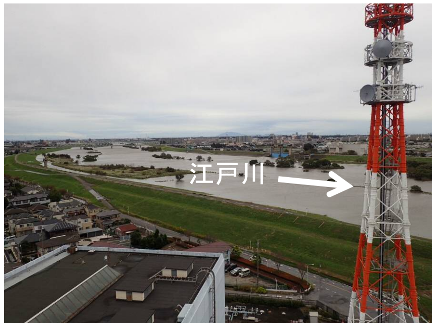
三郷排水機場付近出水状況
