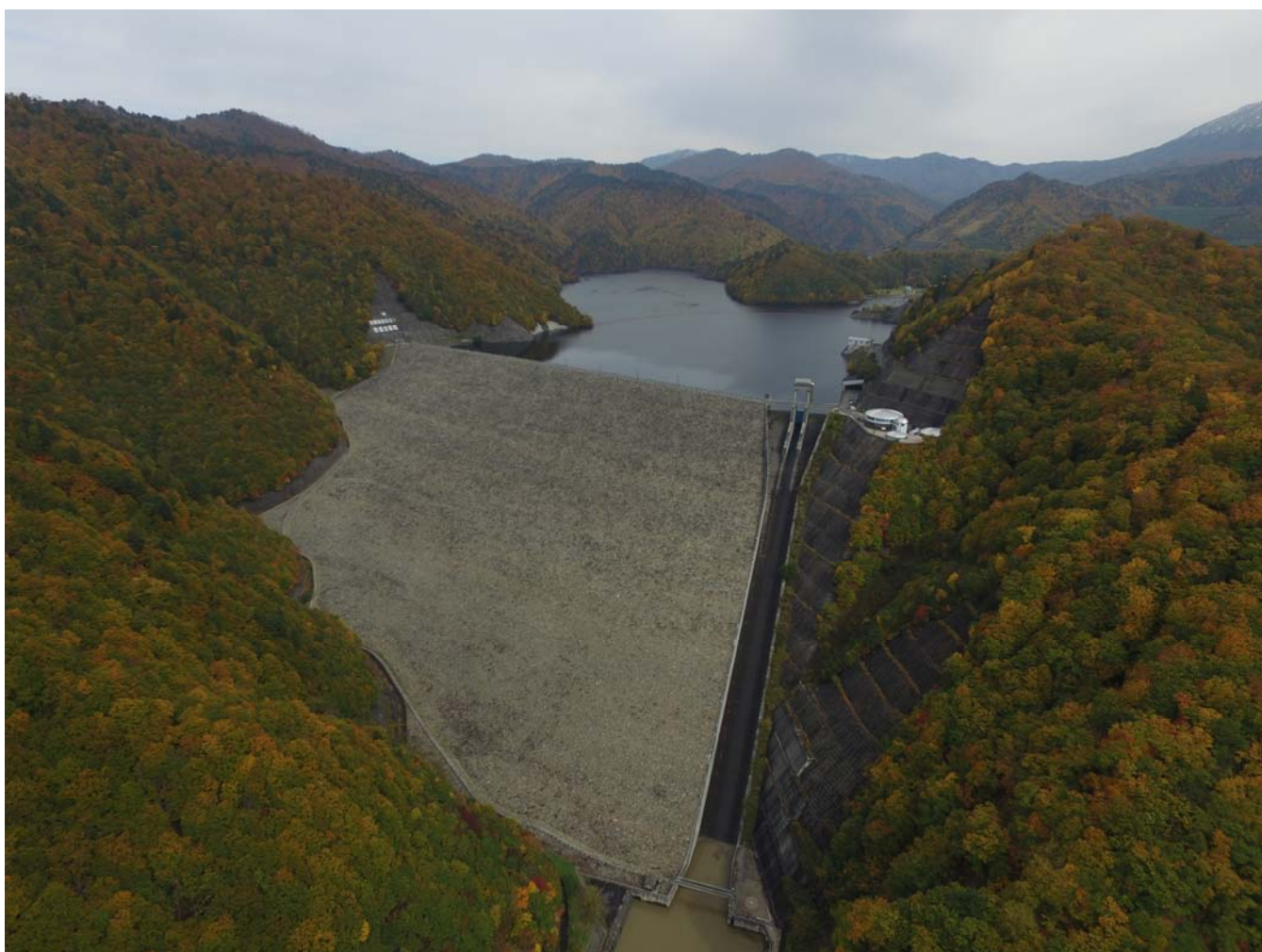
奈良俣ダム（平成29年10月24日撮影）
