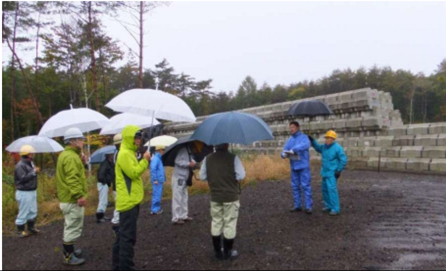
長野県側：濁川砂防堰堤（暫定緊急対策施設）
