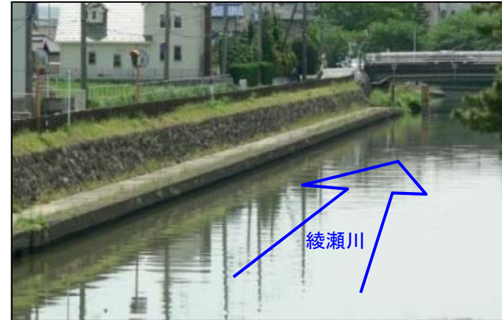
高水敷のない直立護岸で水辺に近づけない
