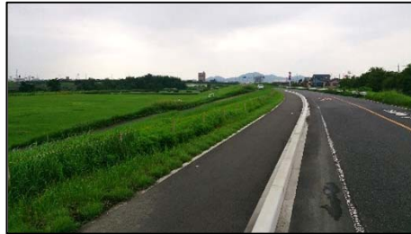
管理用通路の整備
