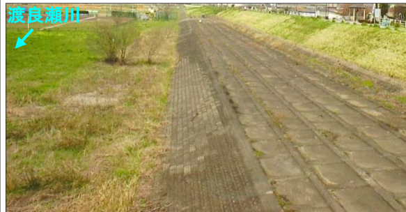
急な法面と凹凸なコンクリートにより、堤防を利用しにくい
