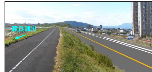
高い堤防によって渡良瀬川へアクセスしにくく、また河川敷は樹木や草木が繁茂し、水辺を利用しにくい
