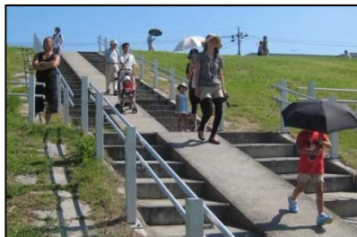
緩傾斜堤防の階段の利用
