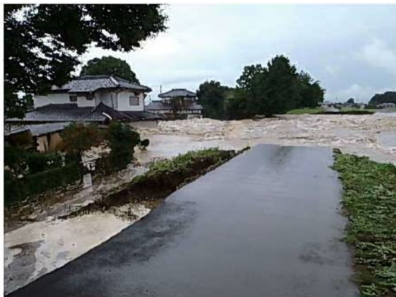
決壊箇所(常総市)
