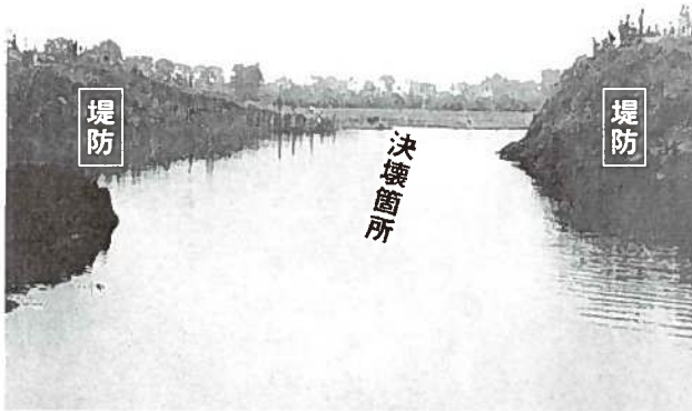
堤防決壊地点の様子 (熊谷市久下地先)
