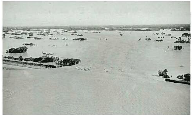
ひがし けっかい 利根川 東村(現・加須市)の決壊状況
