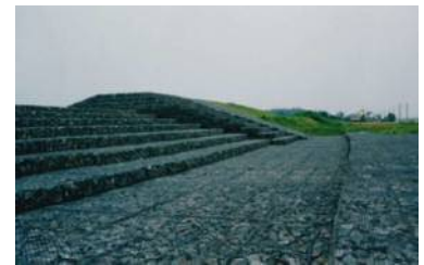
越流堤「キヌマット」施工
