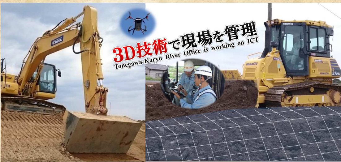
ドローンによる3次元測量、マシンコントロール建機等のICT技術を活用して現場を管理しています
