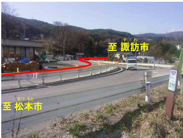
写真① 線形不良区間の状況
