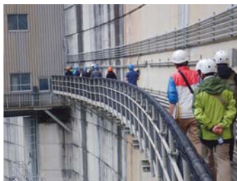
同左(川治ダム)
