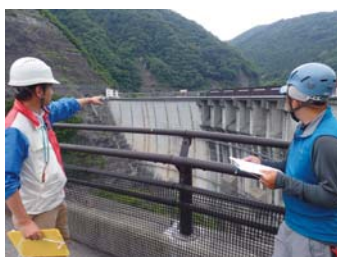
同左(川治ダム)
