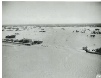
利根川決壊口（旧東村）の状況
