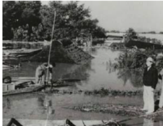
旧川辺村の浸水状況
