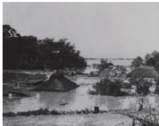
旧川辺村の浸水状況
