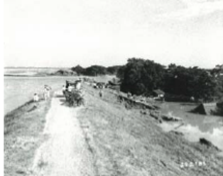
利根川決壊口（旧東村）の状況
