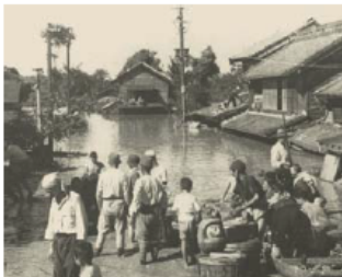
栗橋町の浸水状況
