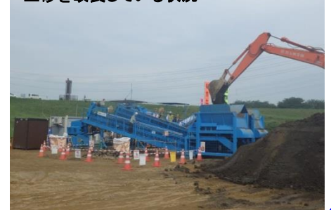
土砂を改良している状況
