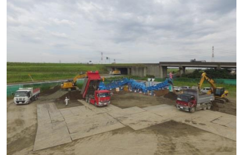
土砂を改良している状況
