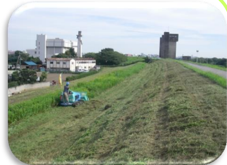
江戸川左岸 松戸市主水新田付近の除草中
