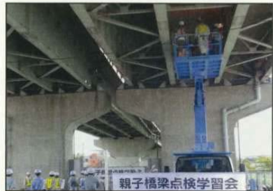
高所作業車に乗って、橋の裏側を点検
