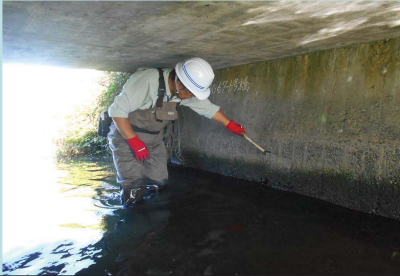
点検ハンマーによる打診や近接目視
