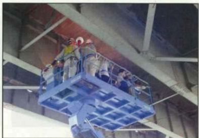
ひび割れや、塗装の剥がれを間近で確認
