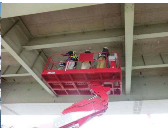
<近接目視点検>
