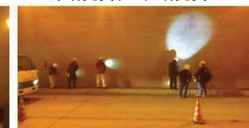
点検実習(打音点検・クラック調査)
