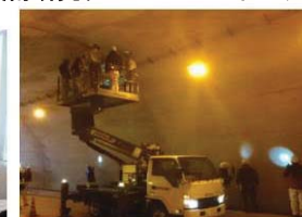
高所作業車による近接点検
