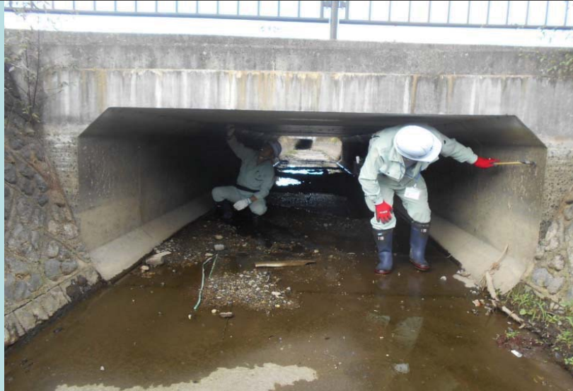
点検ハンマーによる打診や近接目視
