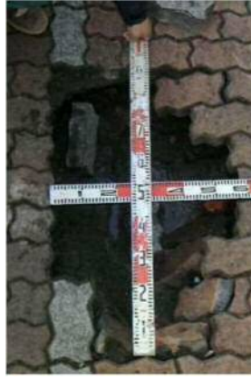
路面陥没 約0.6m × 0.9m × 0.35m(深さ)
