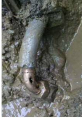
水道管の破損
