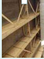
少数桁橋 (二次部材削減)
