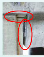
支承交換や桁端点検の空間なし
