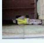
支承交換や桁端点検の空間なし
