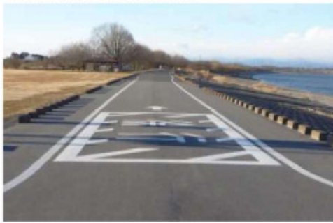
路面標示「徐行」、路側帯の拡幅
