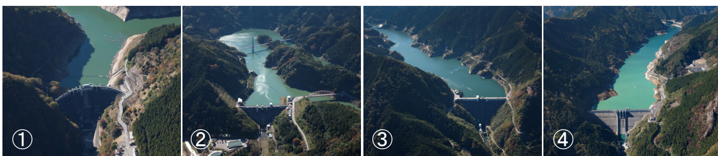
① 二瀬ダム
