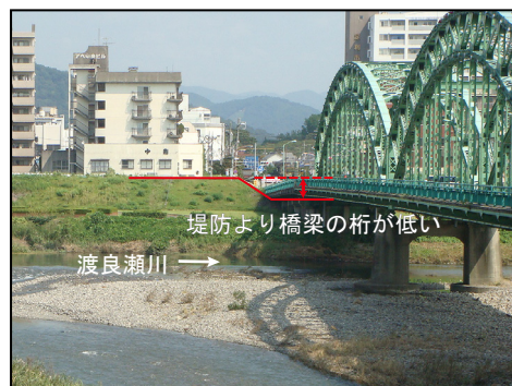
▲中橋（渡良瀬川）
