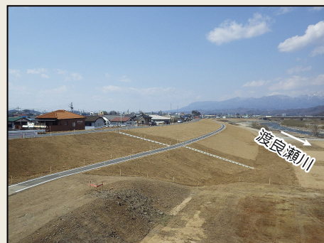
▲整備後の堤防（桐生市相生町）
