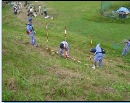
▲堤防の点検状況
