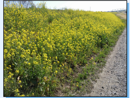
▲堤防の維持管理が必要な事例 (カラシナ繁茂による堤防の弱体化)
