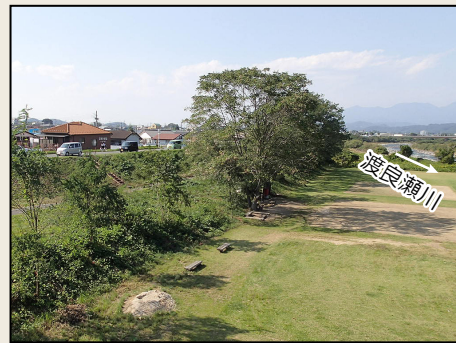
▲断面不足の堤防（桐生市相生町）
