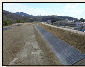
▲法面補修完成
