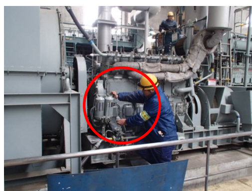
写真-2 オイルフィルター部からのサンプリング
