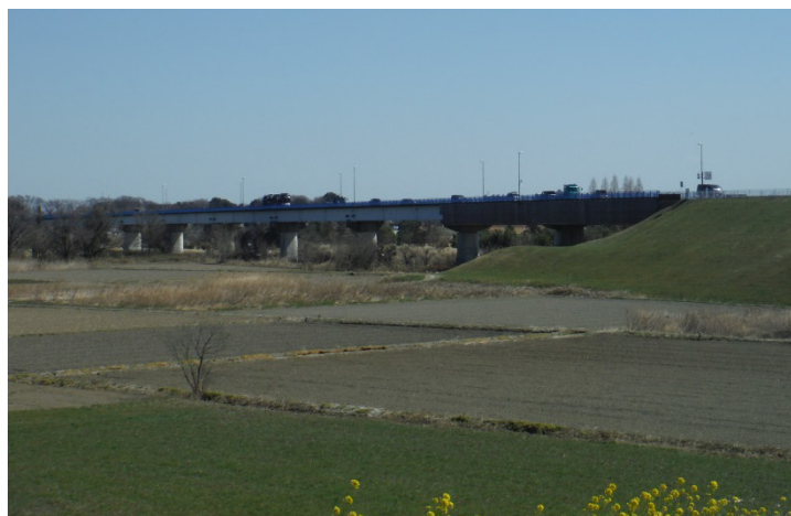
地上から見た開平橋
