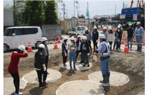
施工現場の見学
