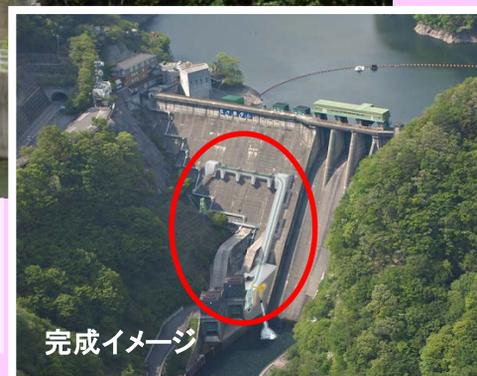
「選択取水設備」を新たに設置しています。
