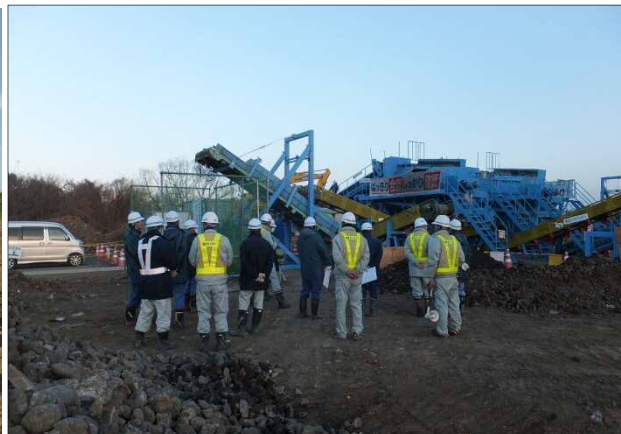
盛土混合処理の見学会
