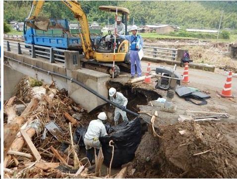
【茶屋の瀬新橋被災状況調査】
