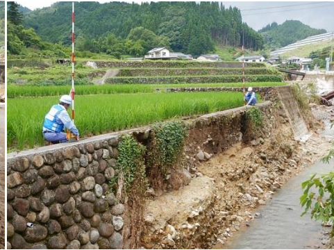
【古城原川被災状況調査】
