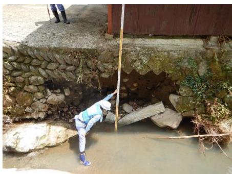
【五郎丸川被災状況調査】
