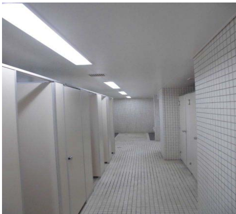
便所全景(大便器ブース側)
