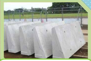
堤防に階段ブロックを883個設置します。なんと1個あたり1.1トンもあるんです。
