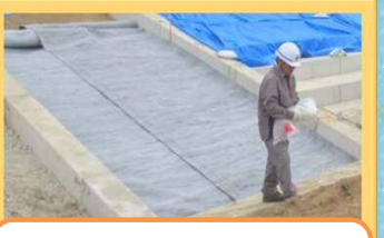
階段の下には、土砂が漏れ出すのを防ぐためのシートが敷設されていました。
