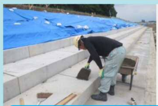
ブロック設置後の仕上げ作業です。各ブロック間にモルタルを詰めて固定します。
