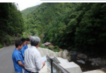
砂防ダムの魚道について
