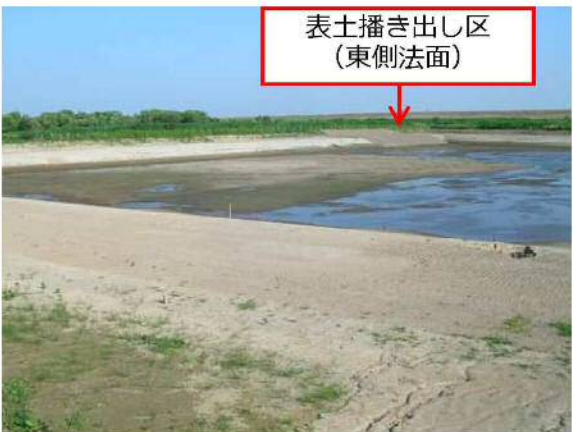
写真 1 施工後の掘削底面（Y.P.+2.8m）を囲む法面と表土播き出し区（平成 22 年 5 月撮影）
