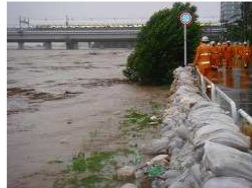
水防活動（土のう積み）
