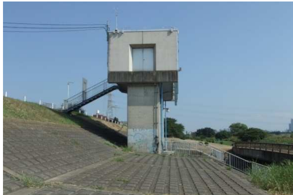
玉川排水樋管
