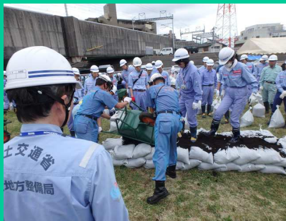
積み土のう工法
