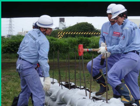
積み土のう工法
