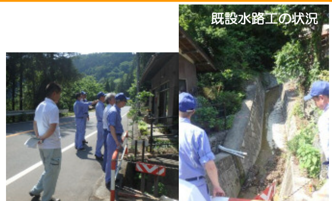
整備した水路工の状況確認調査 （譲原地すべり：藤岡市）
