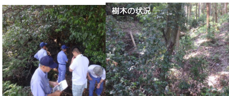
溪流において繁茂する樹木の状況確認調査 （譲原地すべり：藤岡市）
