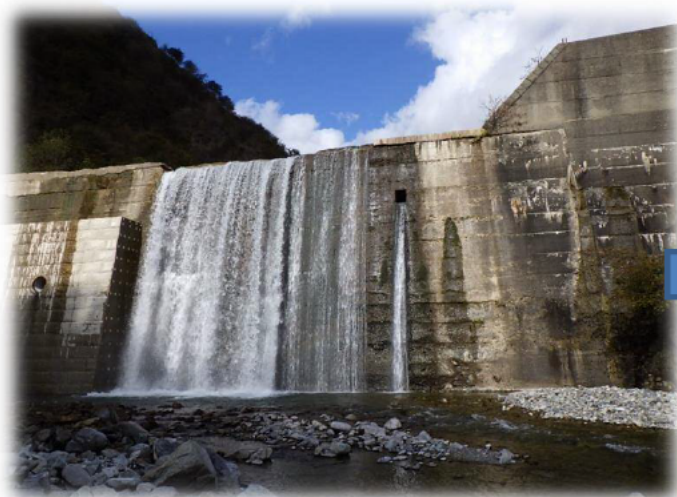
堤体補強施工前
