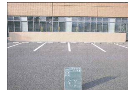
浸水防護壁設置後
