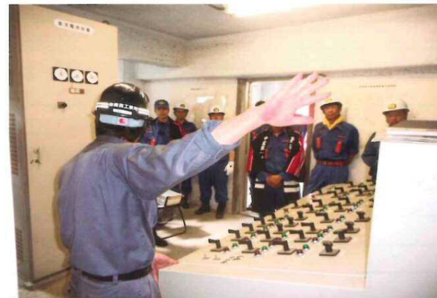
西嶋排水機場 消防団運転説明会 平成28年8月
