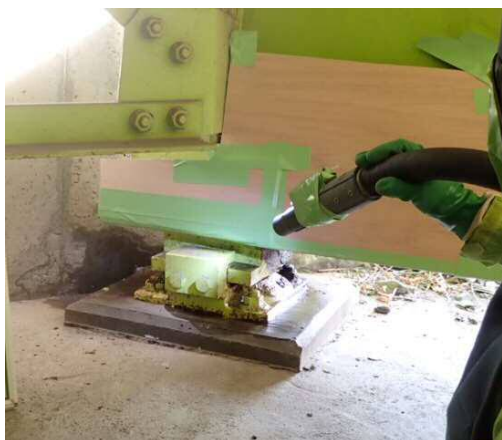
ブラスト処理による素地調整
