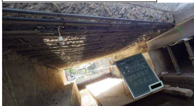
コンクリート脆弱部の除去
