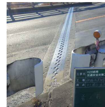
後打ちCo部の劣化
