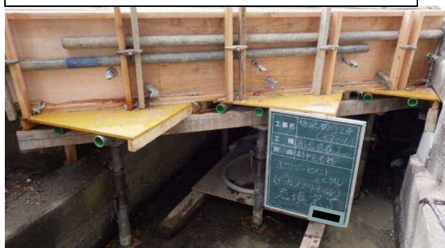
ポリマーセメントモルタル充填
