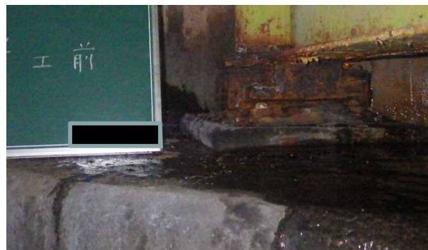
支承部の腐食
