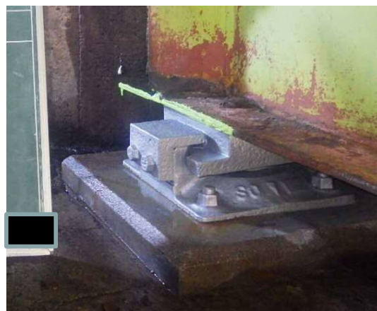
金属溶射による補修完了
