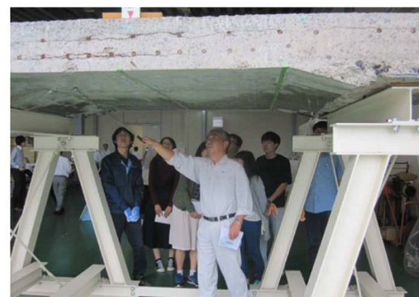
実際に使われていた橋梁断面の損傷を見ながら打音の違いを確認
